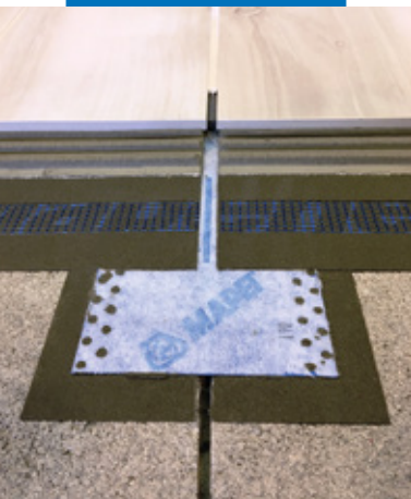
Mapeband Easy položen na radnu dilataciju
